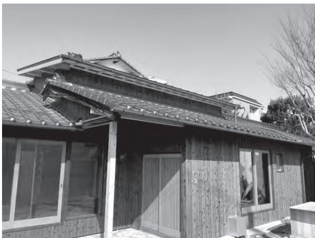
モデル改修中の古民家空き家
